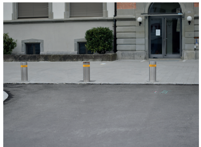
Dissuasore fisso e Dissuasore retrattile Scuole Thal
