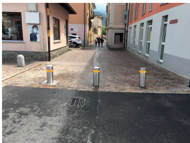
Dissuasore retrattile 2 e dissuasore fisso Caslano
